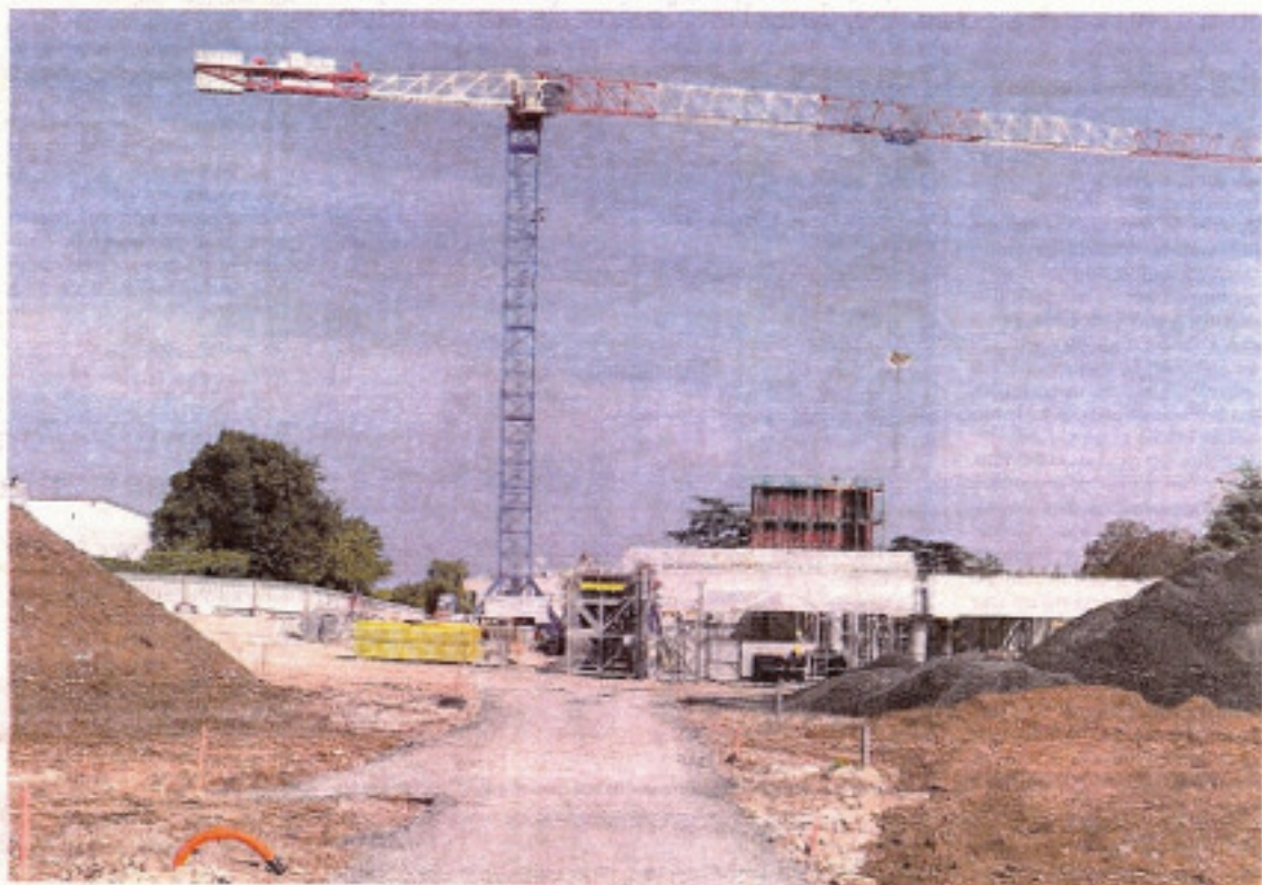
Vue du chantier de l'internat du futur établissement catholique d'enseignement « Isaac de l'Étoile » à Poitiers.
